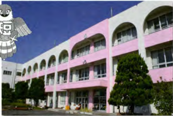
改修を終えた1号館
